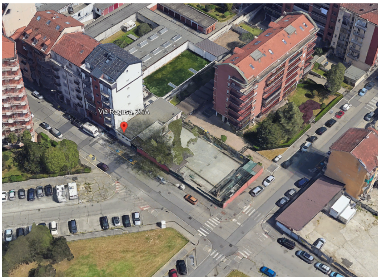
Vista impianto da Google earth
