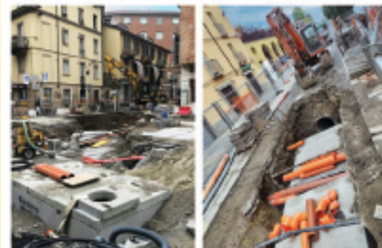
Realizzazione vasca di espansione e collettore 160 x 100 cm in via Borgo Dora
