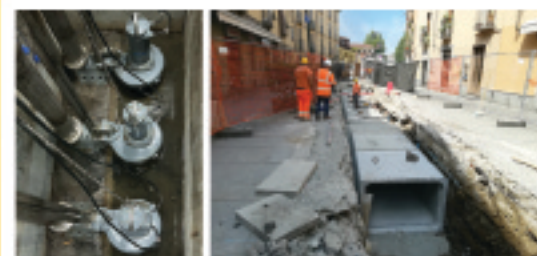
Dettaglio n. 3 elettropompe stazione di sollevamento - Lungo Dora Agrigento (portata complessiva 1.500 l/s) e posa del collettore
