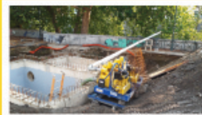
Costruzione vasca della stazione di sollevamento
